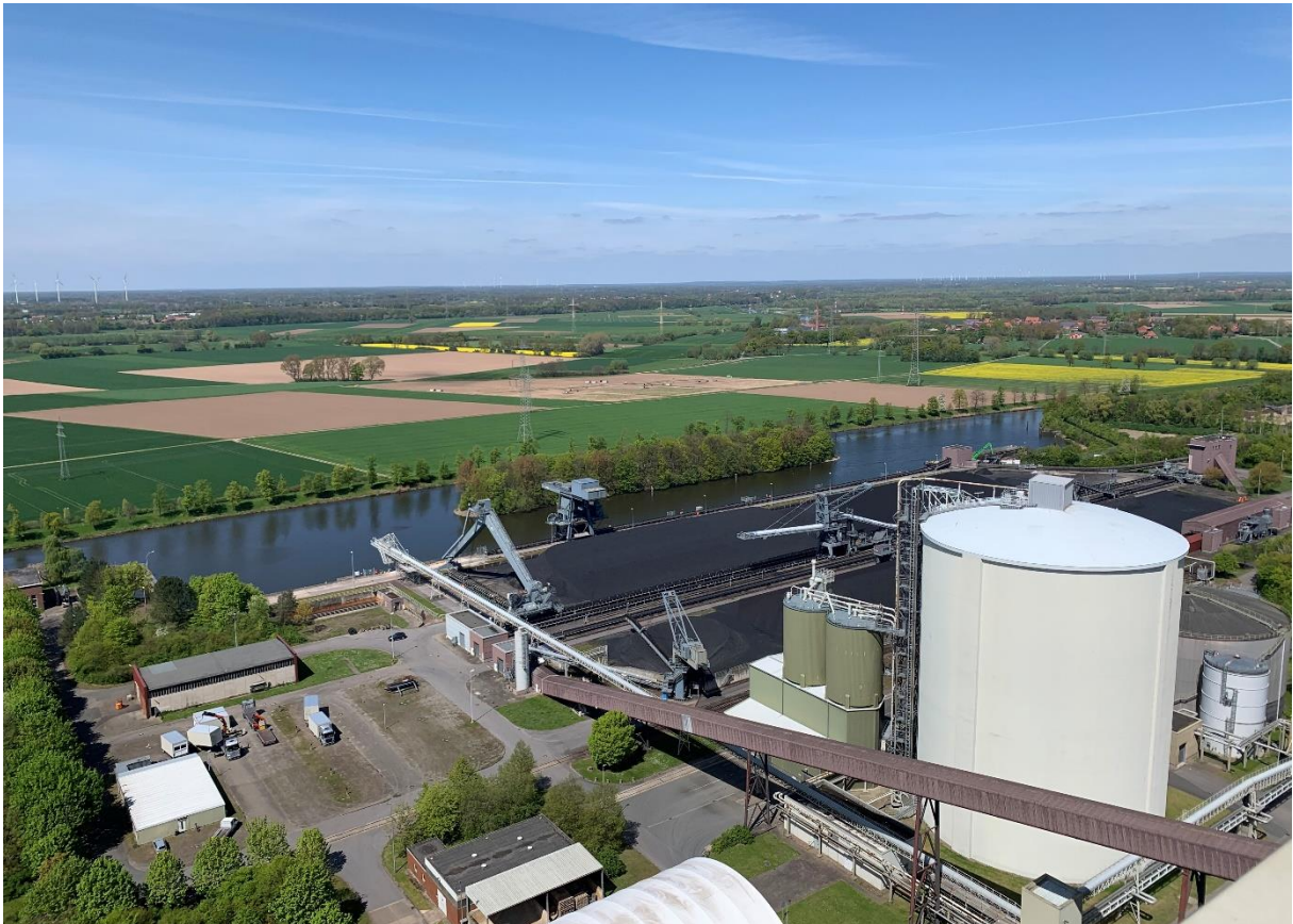
Abbildung 3: Blick vom Kesselhaus nach Westen in Richtung Schleusenkanal
