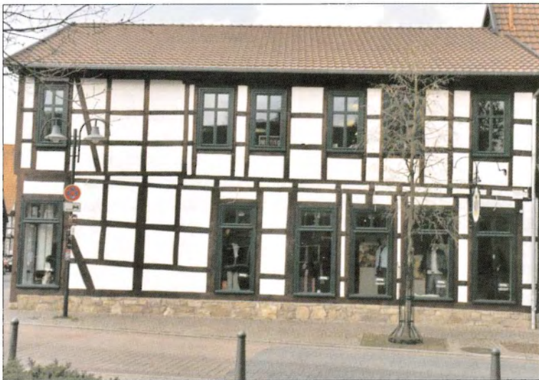
Einzel-schau-fenster im Rhythmus der Fachwerk-konstruktion
