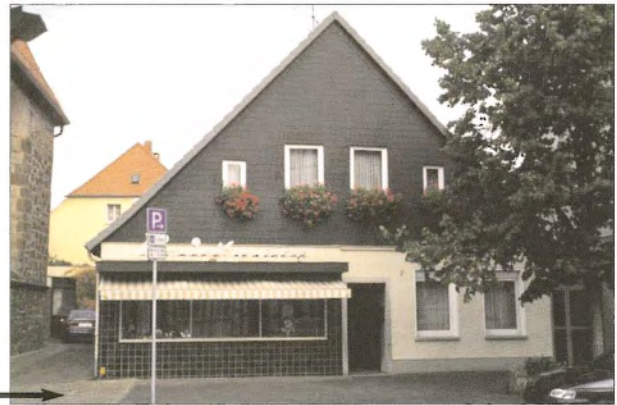
Hauptstraße 7: teilmassive Erneuerung, Verkleidung, Einbau neuer Fenster
