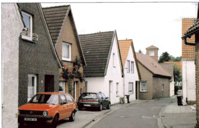
In der Kirchstraße (wie in den anderen kleinen Straßen von Neustadt und Beutelei) wurde auch bei Neubauten das steile Satteldach beibehalten. Unterschiedliche Eindeckungen stören jedoch die Geschlossenheit des Ensembles.
