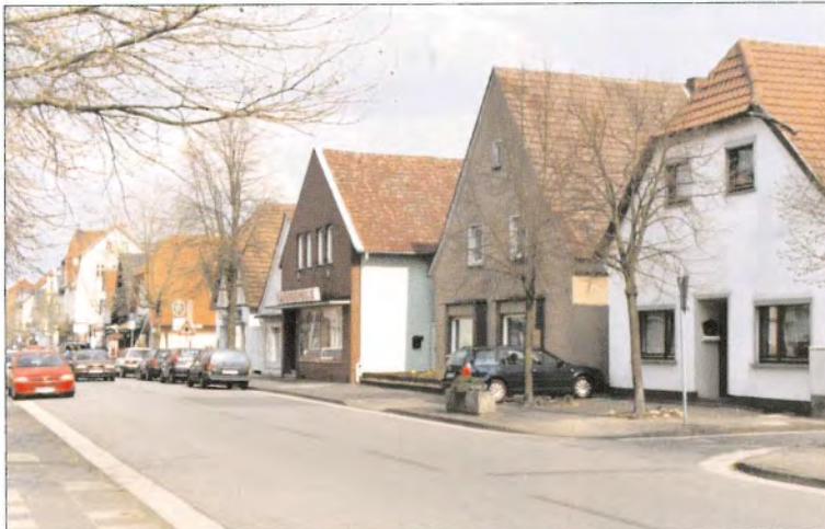
Für den südlichen Abschnitt der Mindener Straße ist die Mischung aus giebelständigen Sattel- und Krüppelwalm-dächern charakteristisch.
