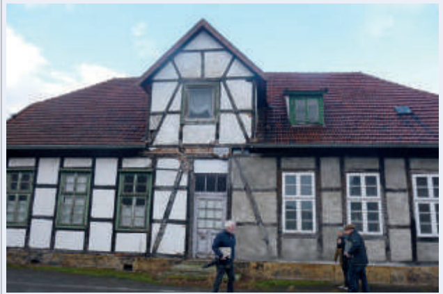
Leerstehendes altes Dorfschulgebäude Lange Straße
