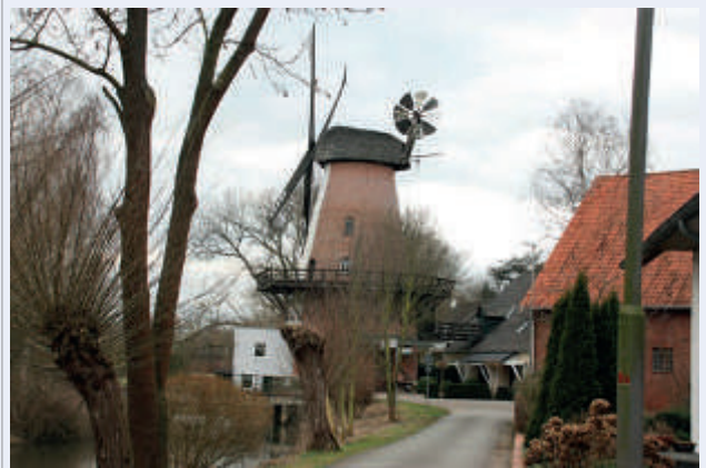
Wind- und Wassermühle Lahde
