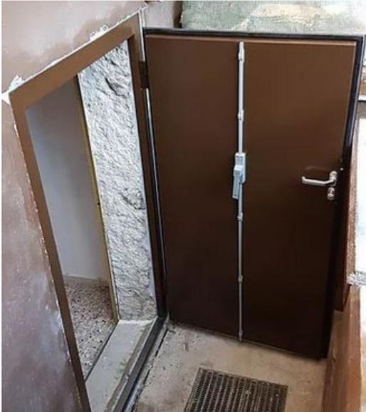
Abbildung 6: wasserdichte Tür (entnommen hochwasserschutz-profis.de, 2022)
