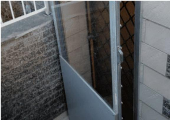
Abbildung 15: druckwassersichere (Keller-)Tür
