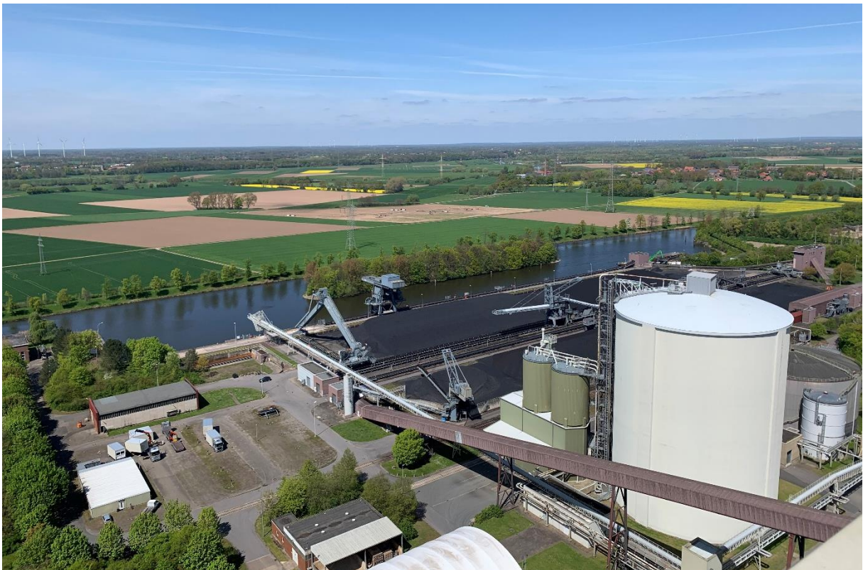
Abbildung 3: Blick vom Kesselhaus nach Westen in Richtung Schleusenkanal
