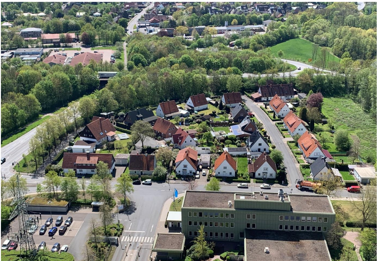
Abbildung 5: Blick vom Kesselhaus nach Süden in Richtung Verwaltungsgebäude / Kraftwerkssiedlung sowie den Verkehrsknotenpunkt mit der B 482
